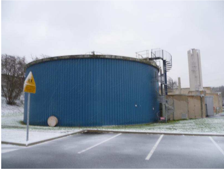
Figure 6 : Digesteur anaérobie mésophile
