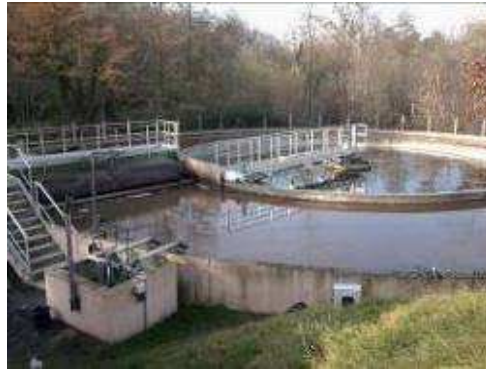
Figure 2: Photographie de la station étudiée
