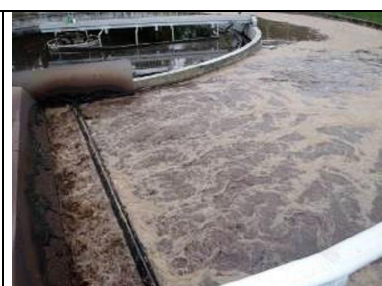
Point de prélèvement boues : bassin aération
