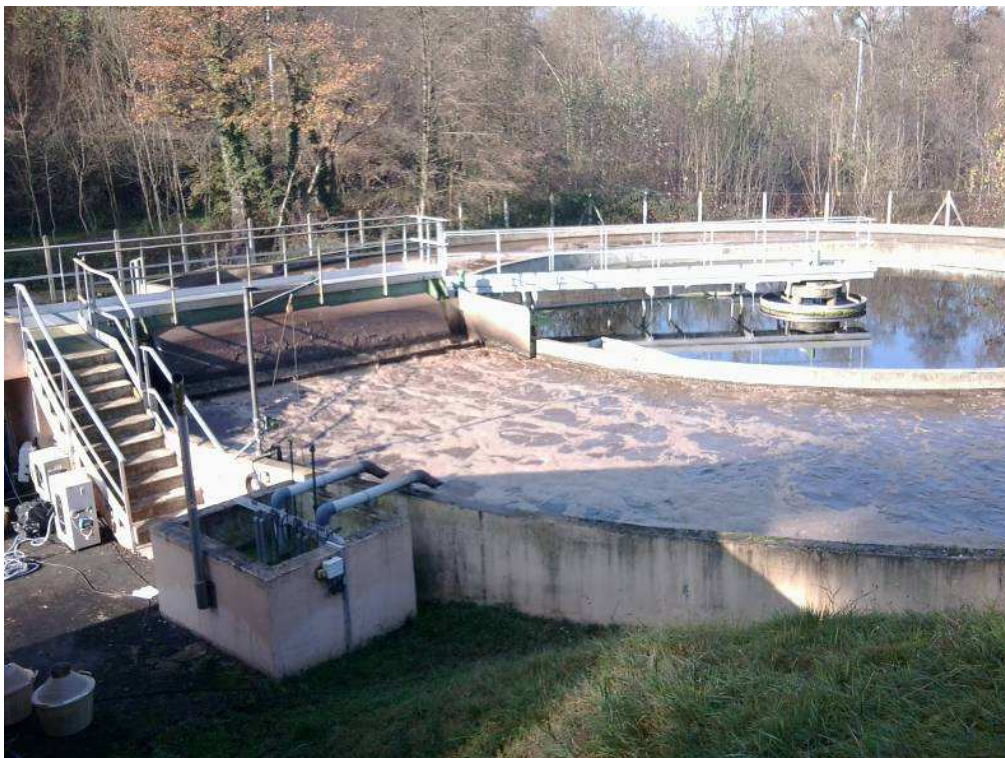
Figure 2 : Photographie de la STEU étudiée (site Dw)
