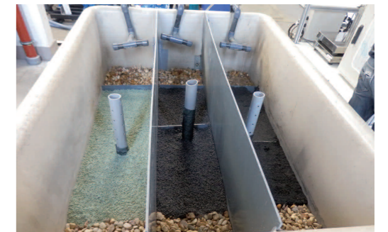
Figure 2. Pilotes garnis de matériaux adsorbants (argile expansée, zéolite et charbon actif).
