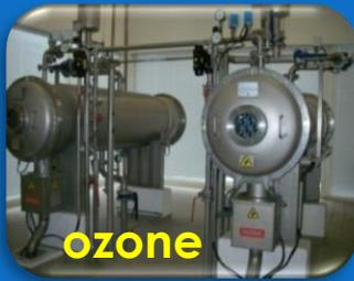
Filtere à sable + Ozone (3 mg/L, 26 min)
