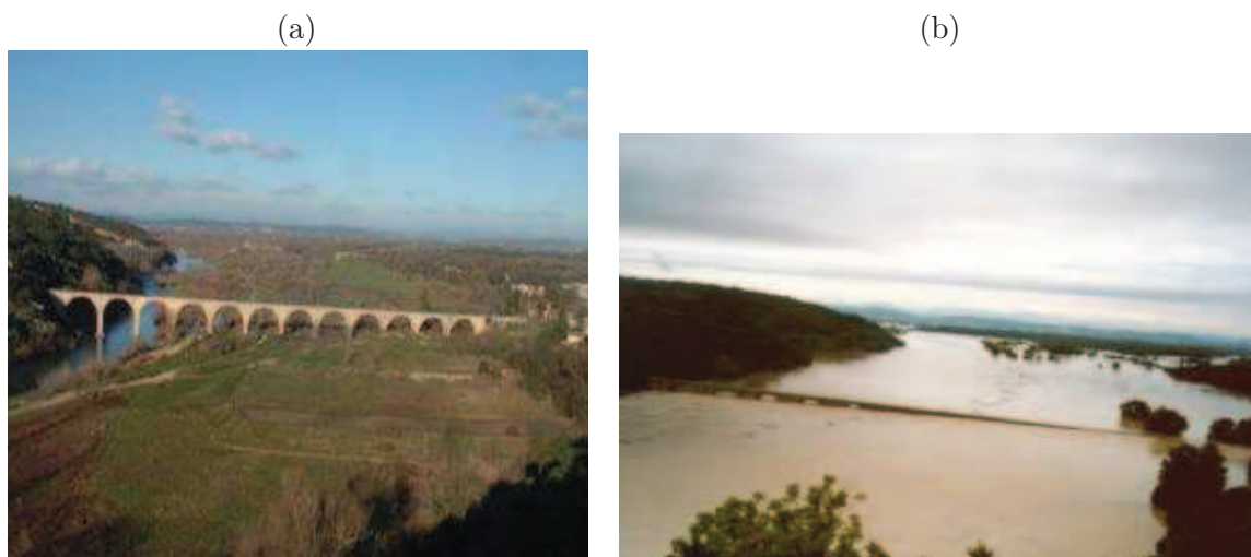
FIGURE 12 – Le pont de Russan (a) à l'étiage et (b) pendant la crue de 2002 (photos du Conseil Général du Gard).
