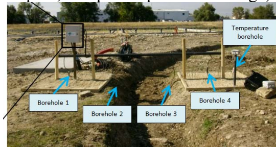
Fig. 2 – Dispositif de mesure de résistivité électrique autour du fossé d'injection (vue année 0, avant développement des végétaux)
